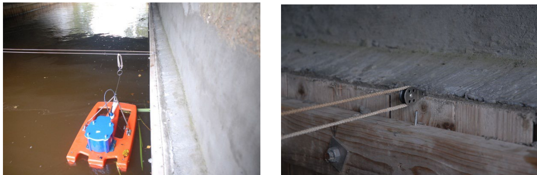
Figur 1. Billedet til venstre viser et eksempel på et ADCP instrument, der er monteret på et wiretræk, opstillet under en bro. Billedet til højre viser blokken der benyttes til wiretrækket.
